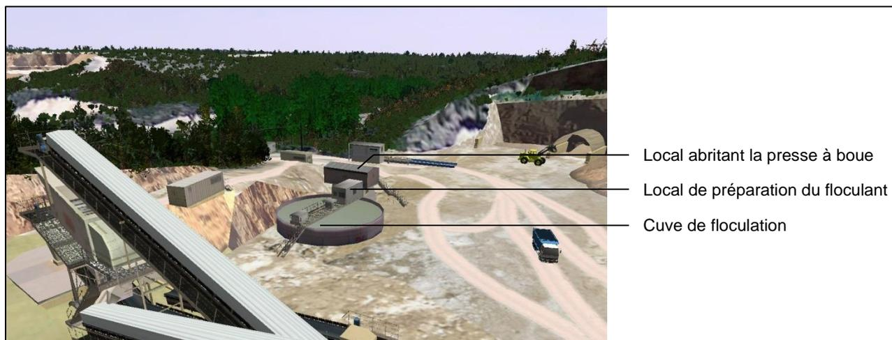
**Figure 16 : Photosimulation de l'installation de traitement des boues de lavage**
